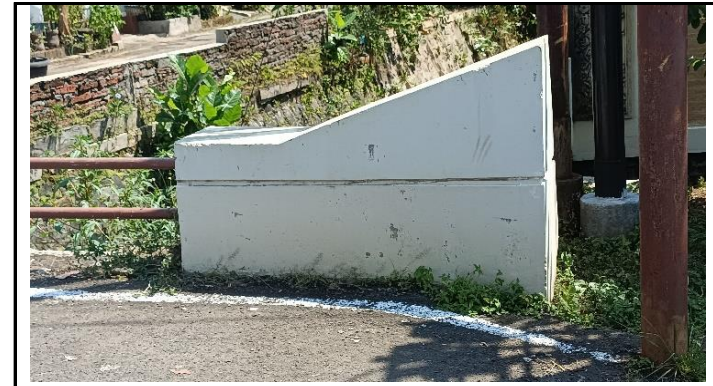
KONDISI SANDARAN DAN PARAPET
