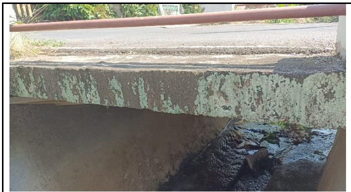
KONDISI KEPALA JEMBATAN DAN PELAT
