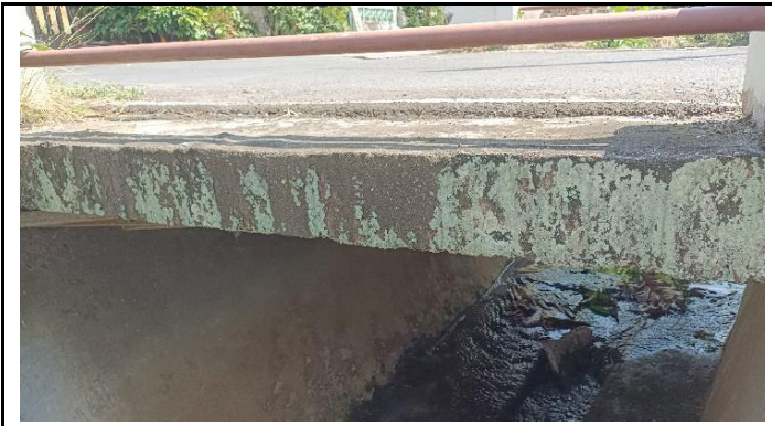
KONDISI KEPALA JEMBATAN DAN PELAT
