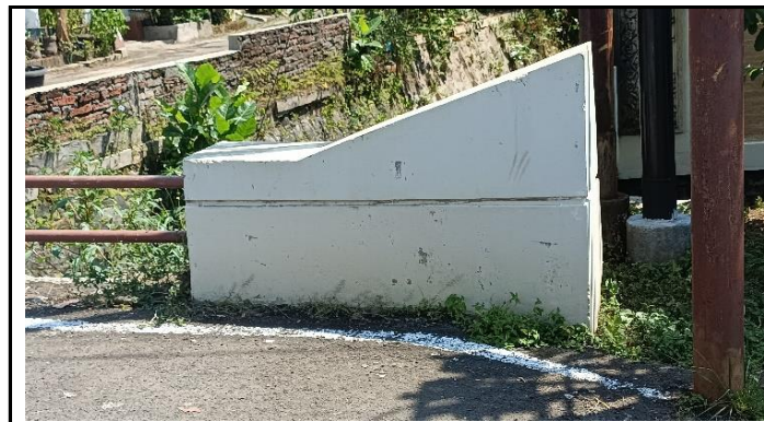
KONDISI SANDARAN DAN PARAPET
